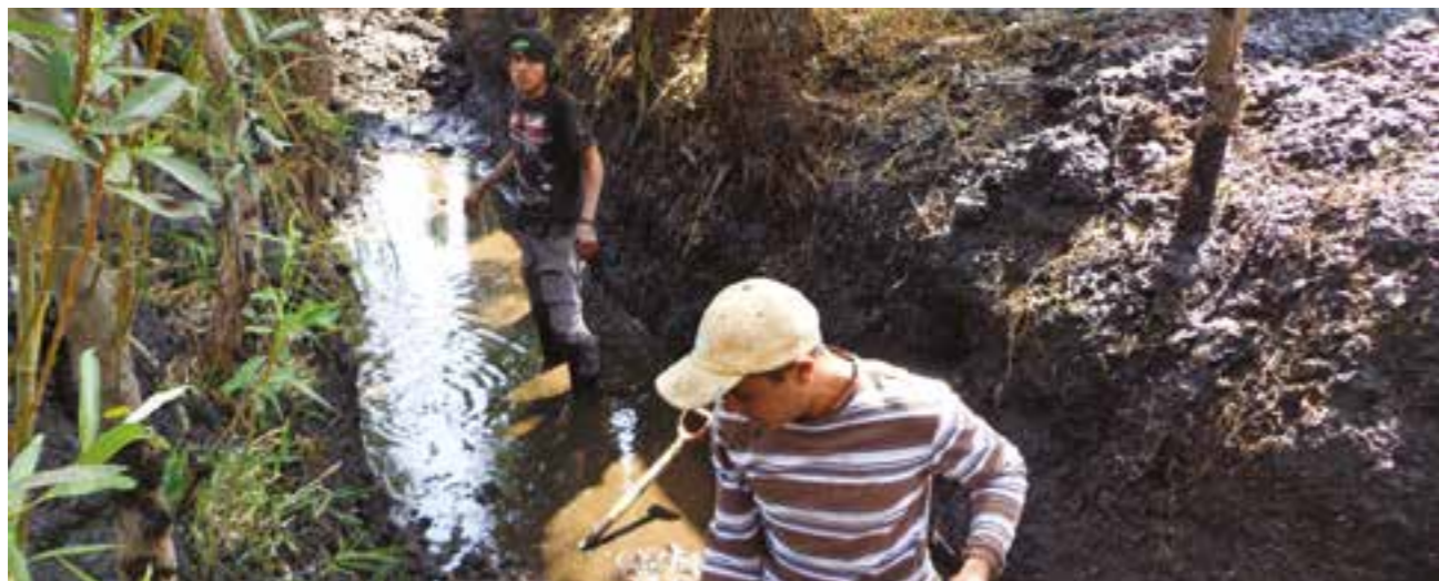
Desasolve y rehabilitación de canales en zona de chinampas en Xochimilco.
