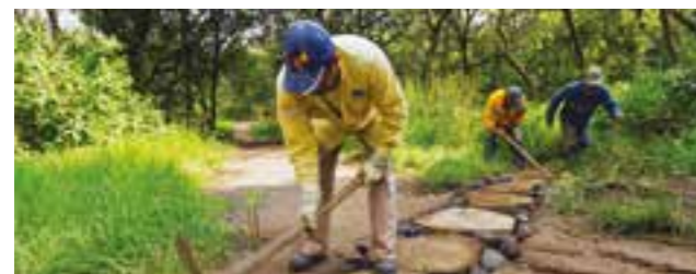
Trabajos de rehabilitación, Bosque de Tlalpan.
