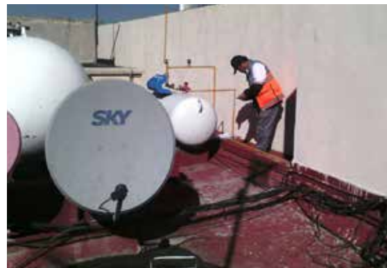
Verificación de instalaciones.
