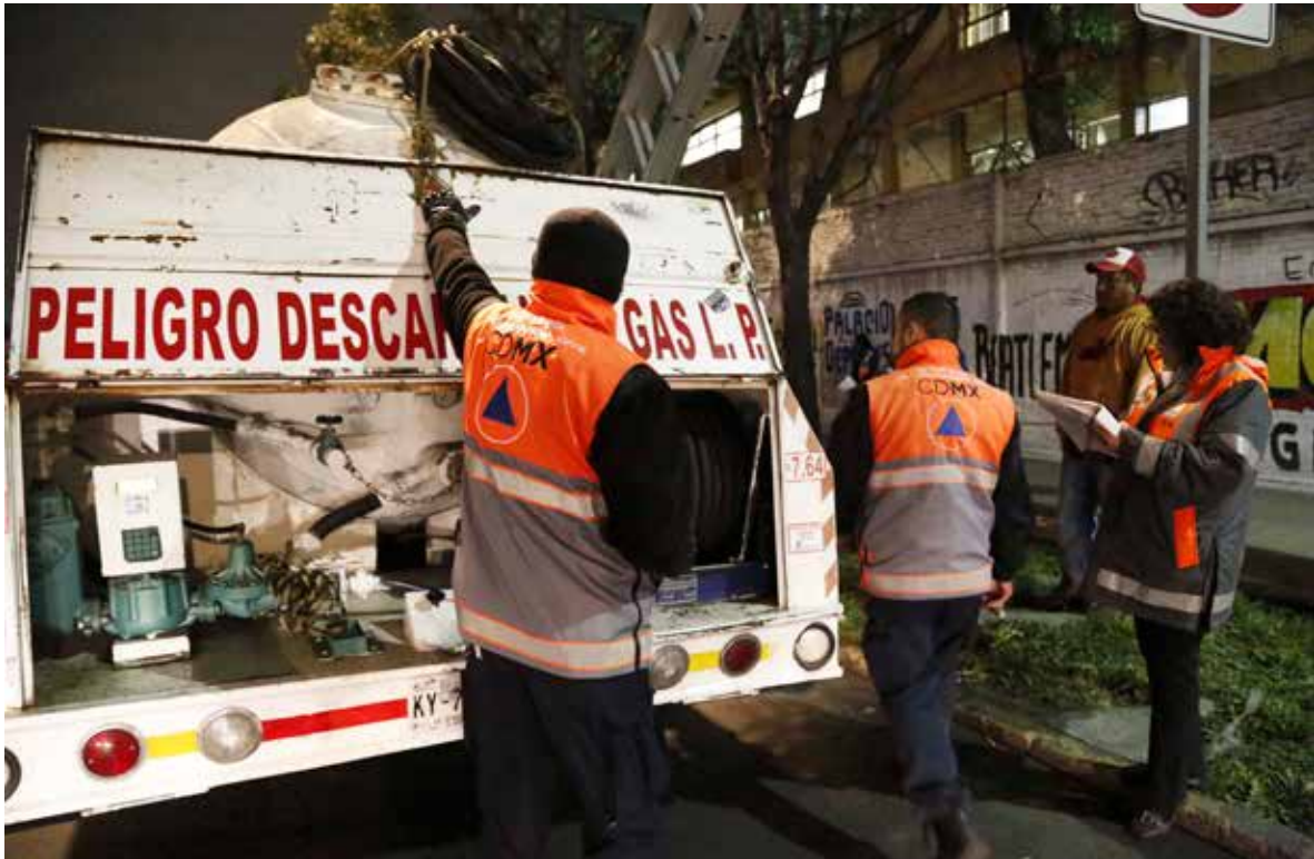
Revisión de Auto-tanques de Gas L.P.
