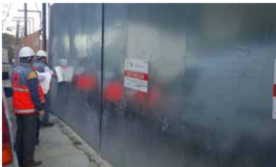
Verificación de construcción en Polanco.
