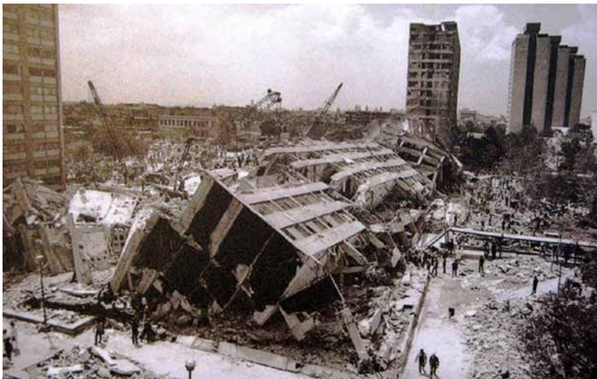
Derrumbe de conjunto habitacional en Tlatelolco por sismos de 1985.
