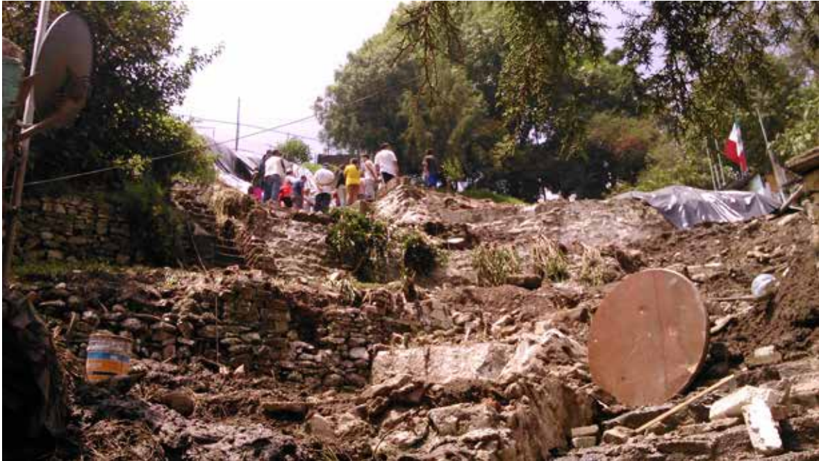
Deslizamiento en una propiedad.
