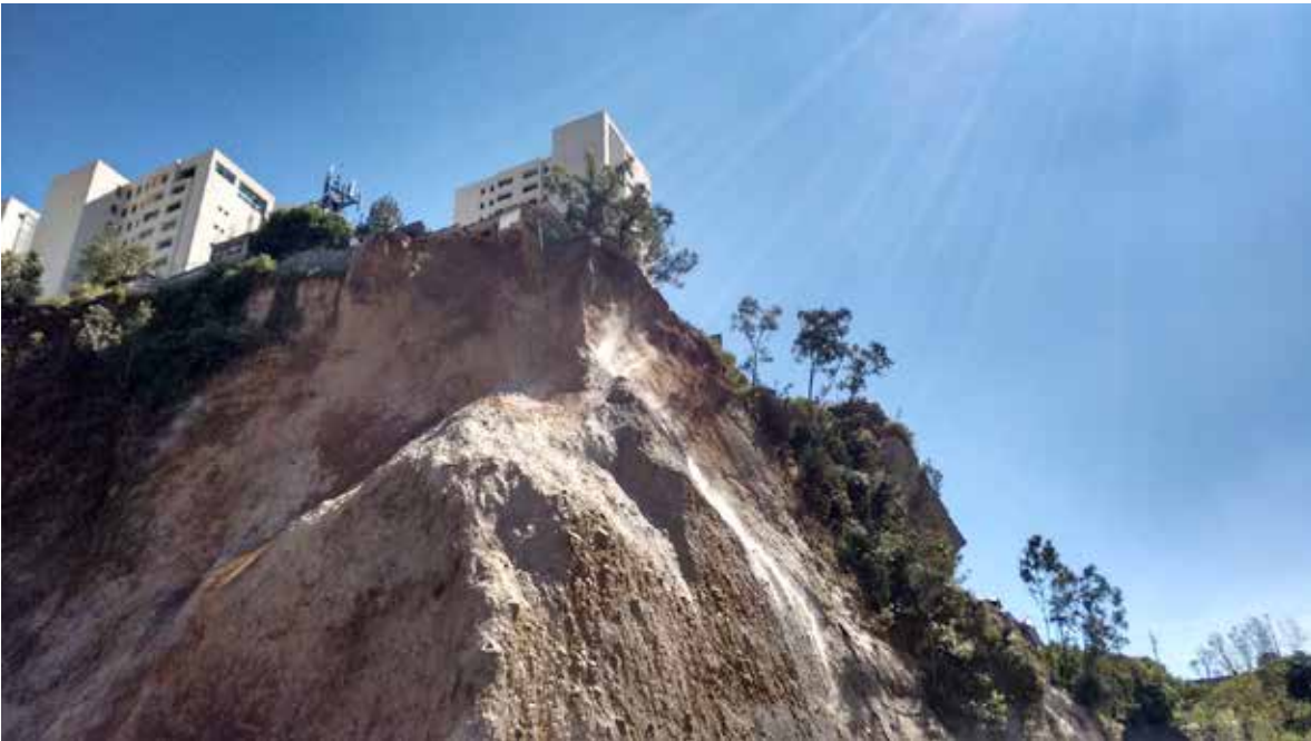
Talud en Santa Fe.
