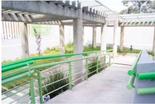
Fuente: Trabajo de campo: rampas de acceso en PILARES Huayatla.
