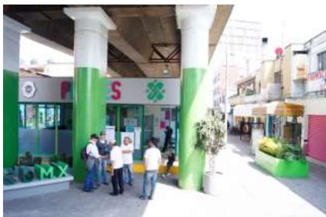
Fuente: Trabajo de campo: fachada de PILARES Municipio Libre, sin protecciones en los ventanales de Ciberescuela.
