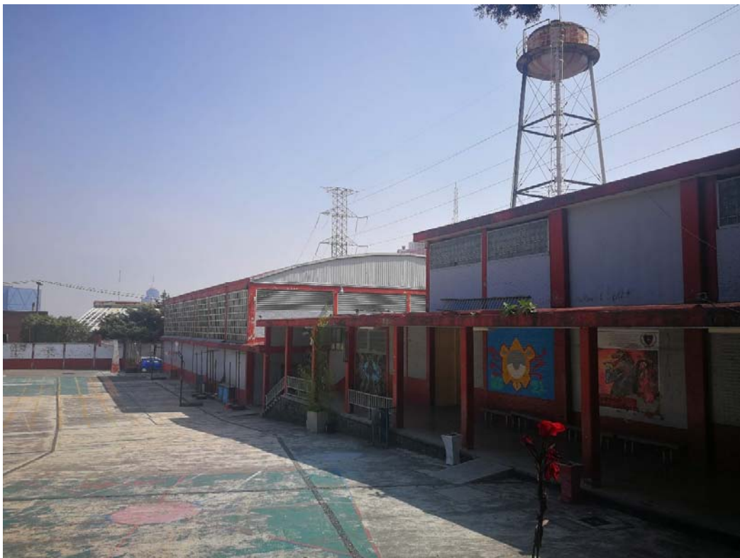
Imágenes 3: Estado de la escuela en general y de los sanitarios después la intervención de Mejor Escuela
