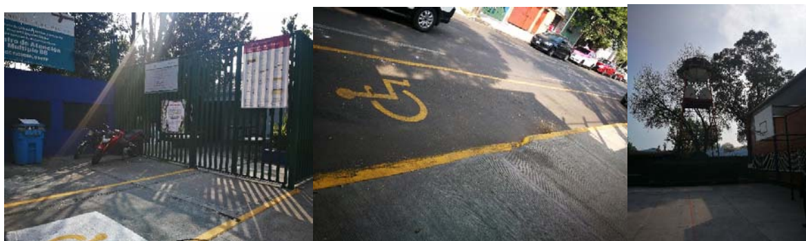
Imágenes 5: Estado de la escuela en general y de las instalaciones de gas después la intervención de Mejor Escuela
