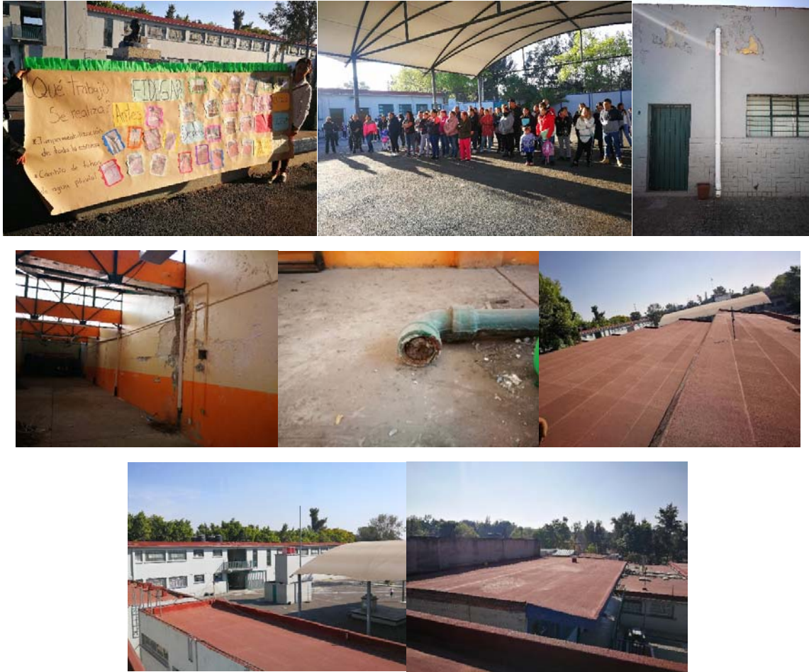
Imágenes 10: Asamblea de rendición de cuentas y de los drenajes de techos e impermeabilización hecha con los recursos de Mejor Escuela
