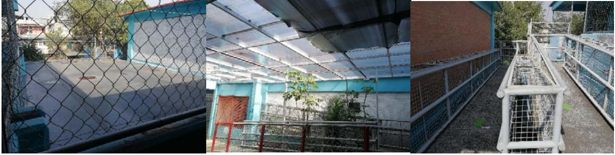
Imágenes 4: Estado de la escuela en general y de la techumbre después la intervención de Mejor Escuela
